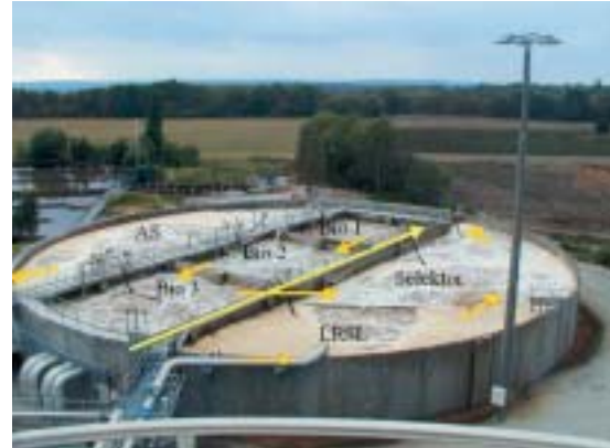
Reningsanläggningen vid Mörrums Bruk utgörs av en biologisk reningsanläggning av typ Multibio som togs i drift våren 2002.
